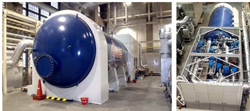
日本三菱重工200kW SOFC MGT 联合系统
